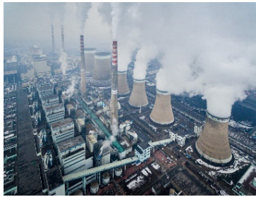
Abb. 1: Kohlekraftwerk in der Provinz Shanxi 3)
